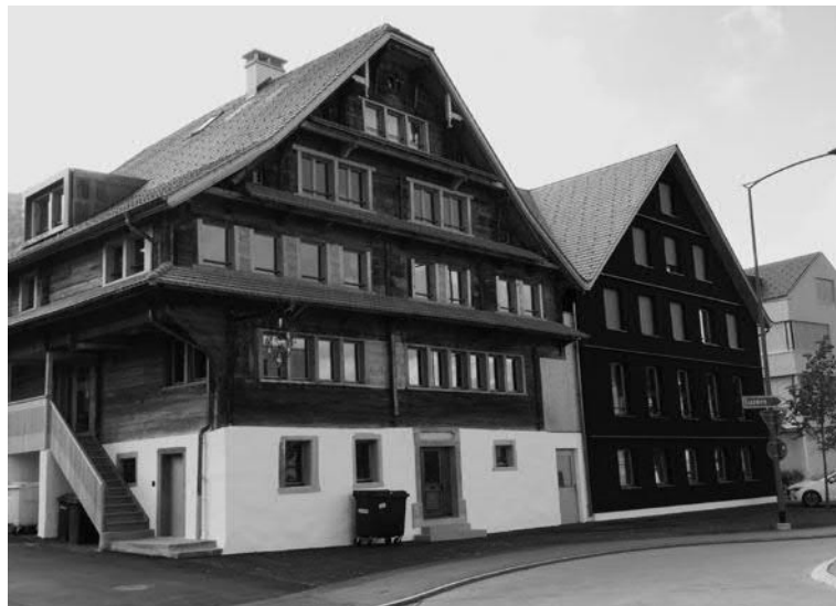
Das Rössli mit neuem Anbau 29. Juli 2019
