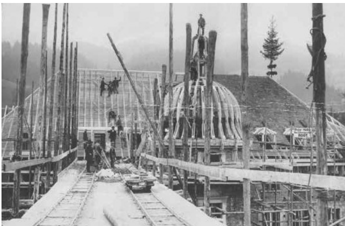
Nr. 5: Zimmerleute an der Arbeit am Neubau Schulhaus St. Martin ca. 1925
