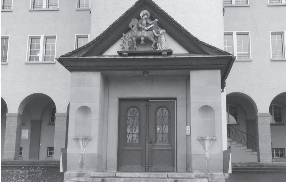
Foto 1: Rooter Sandstein am Haupteingang des Schulhauses St. Martin
